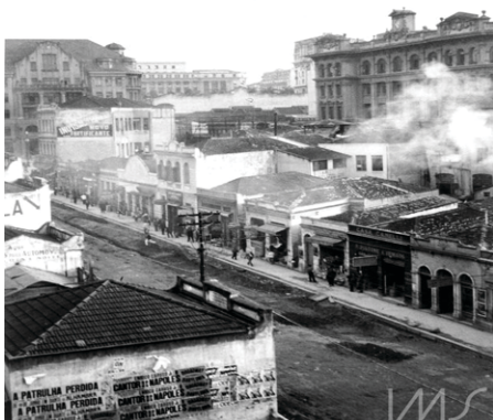
Rua Anhangabaú, 69 do alto a partir da rua Líbero Badaró Lévi-Strauss, década de 1930.
