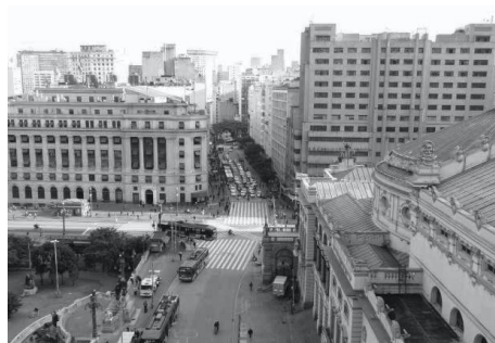
Vale do Anhangabaú, 66 à direita edifício Alexander Mackenzie, sede atual Shopping Light e à esquerda visto desde o Hotel Esplanada, hoje órgão público da prefeitura da cidade, 2016.
