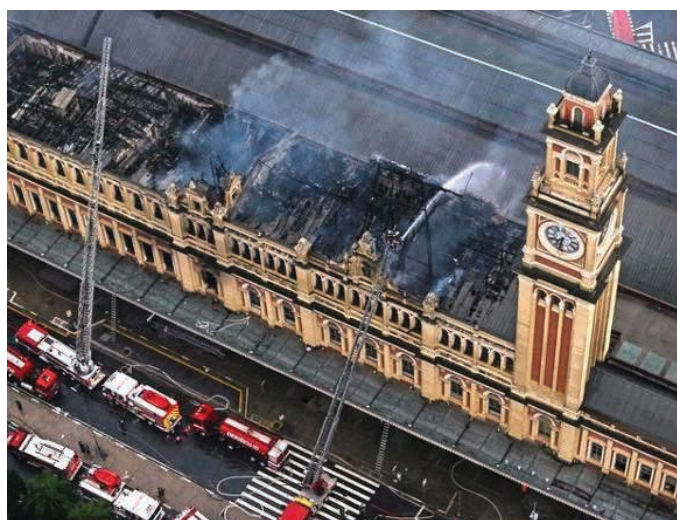
Figura 11: Vista panorâmica do incêndio no MLP, na Estação da Luz
