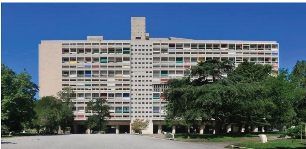
Figura 2: Unidade Habitacional de Marselha – Le Corbusier, França, 1947-1953
