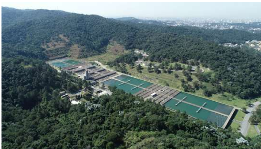
Figura 3: Sistema de Tratamento de Água Guaruaçu. Fonte: Site da Sabesp 24 .
