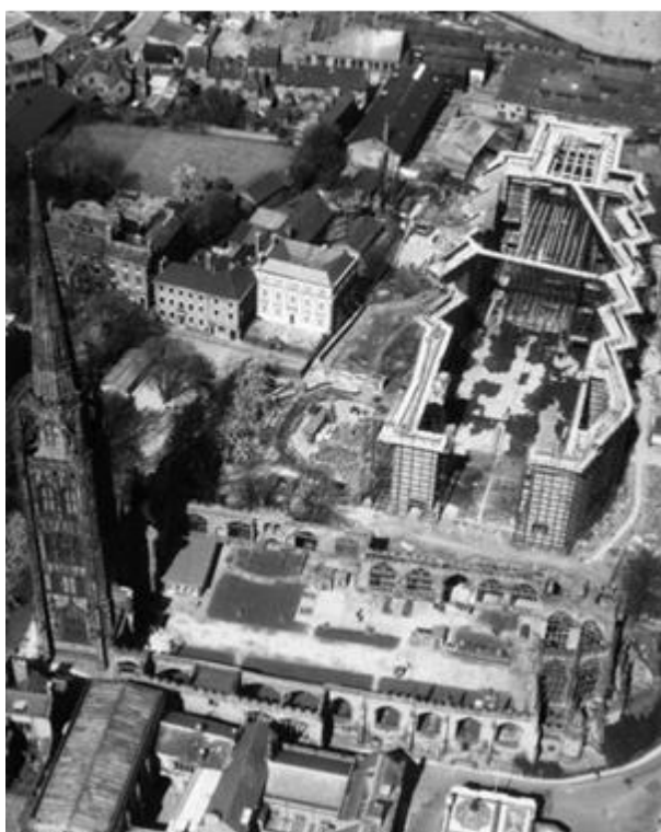
Fig. 5. Vista aérea durante as obras de construção do novo edifício, com as ruínas da antiga Catedral em primeiro plano. Fonte: The Sir Basil Spence Archive Project
