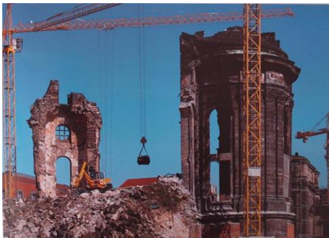
Fig. 12: Início do canteiro de obras, em que se selecionou e catalogou o material remanescente, com vistas ao seu aproveitamento na reconstrução. Fonte: Zumpe, 2005, p. 7
