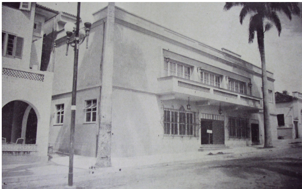
Figura 01 – Fachada do Cine-Teatro Cuiabá, 1942.
