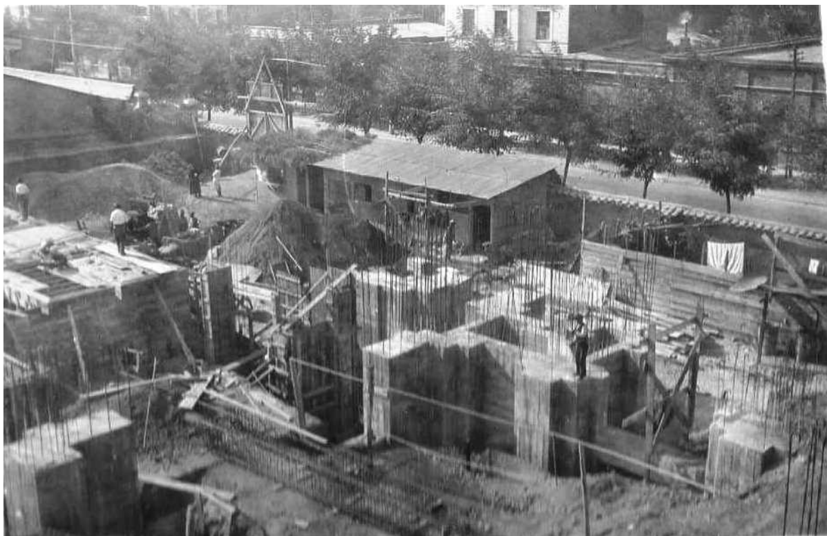
Imagen 1: obras de construcción del templo. 14
