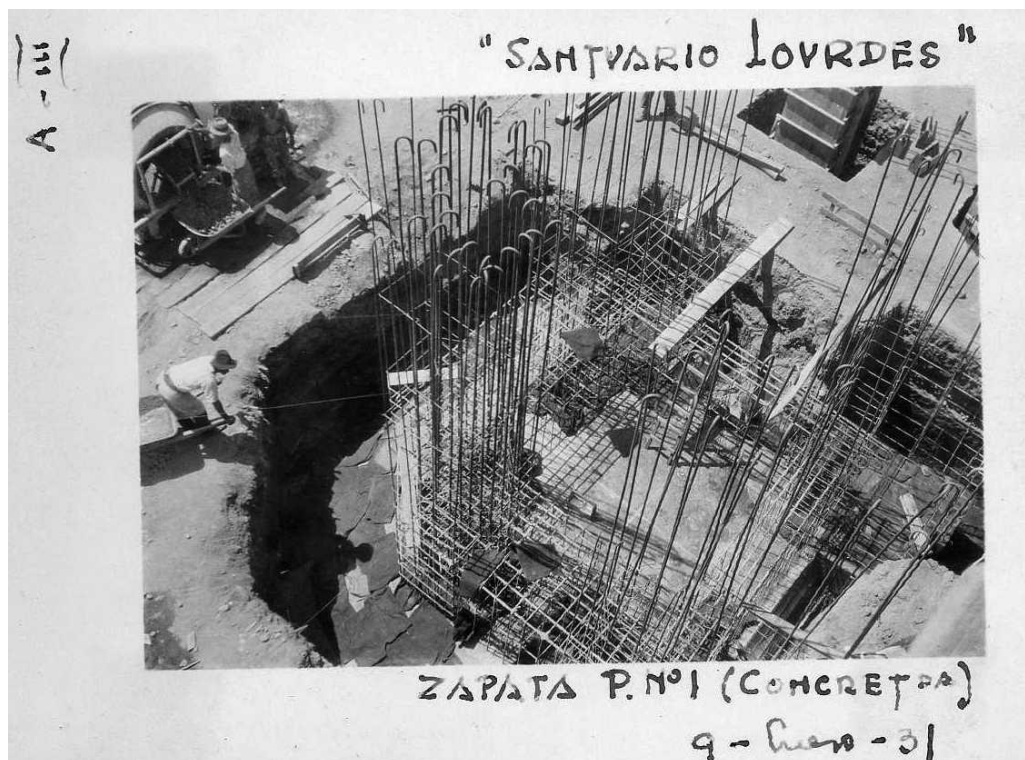
Imagen 3: obras de construcción del templo.
