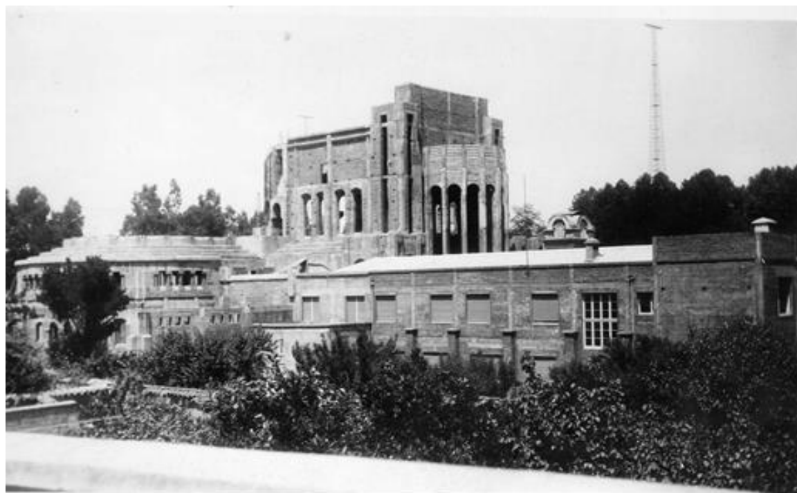
Imagen 2: obras de construcción del templo.
