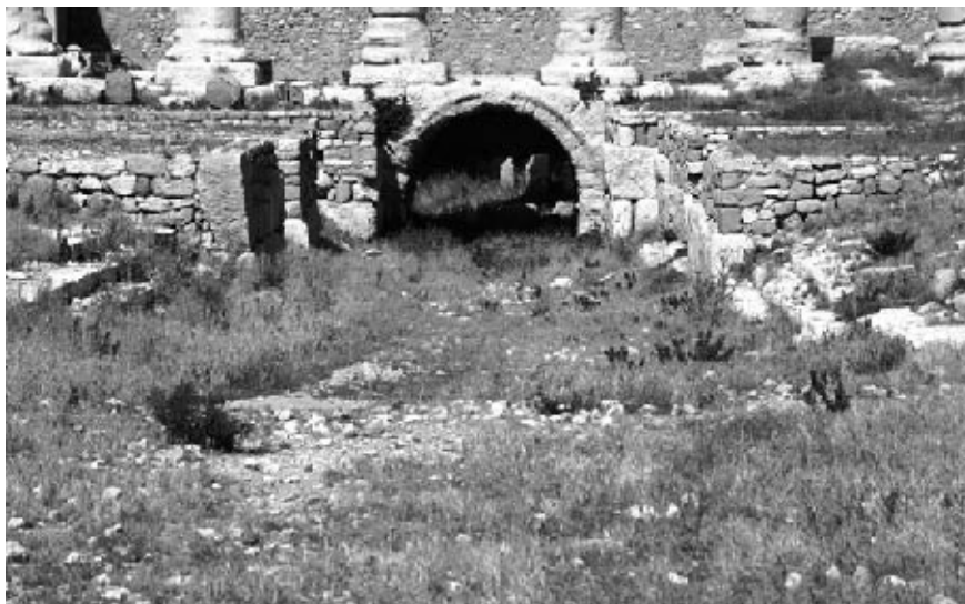
Túnel sob peribolo – estrados
