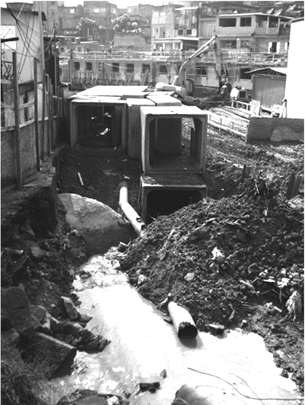
Figura 3 – Canalização de córrego em galeria no Jardim Guarani
