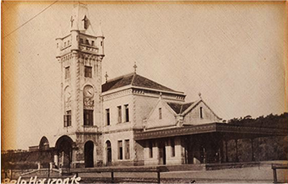
Figura 1 – Primeiro prédio da Estação Central do Brasil, na Praça da Estação (1905). Demolido no início da década de 1920
