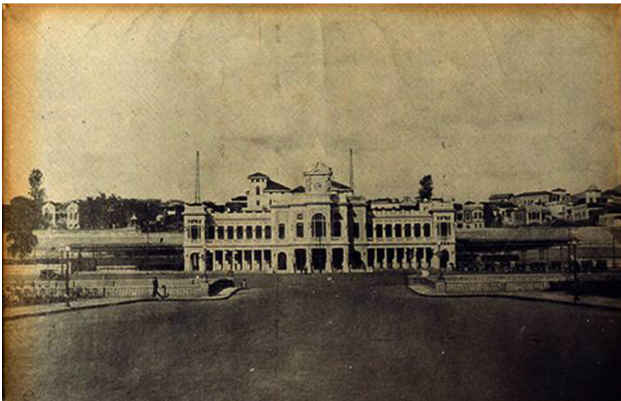
Figura 2 – Vista do prédio da Estação, a partir do eixo da antiga Av. do Comércio (hoje Av. Santos Dumont). Inaugurado em 1922
