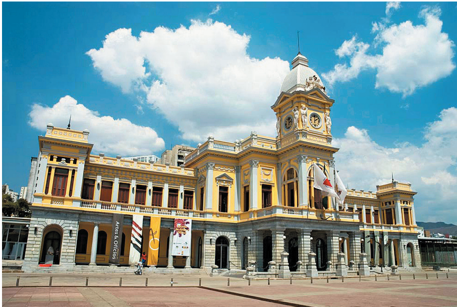
Figura 4 – Vista da fachada do Prédio da Estação Central de Belo Horizonte – Sede do MAO
