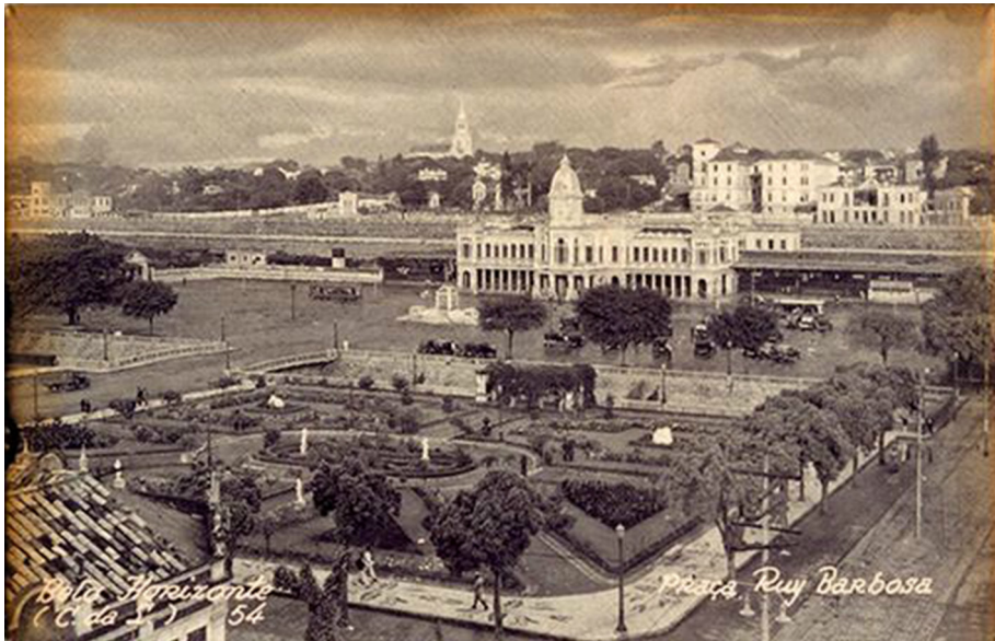
Figura 3 - Vista Parcial dos Jardins e dos edifícios da Praça em 1954
