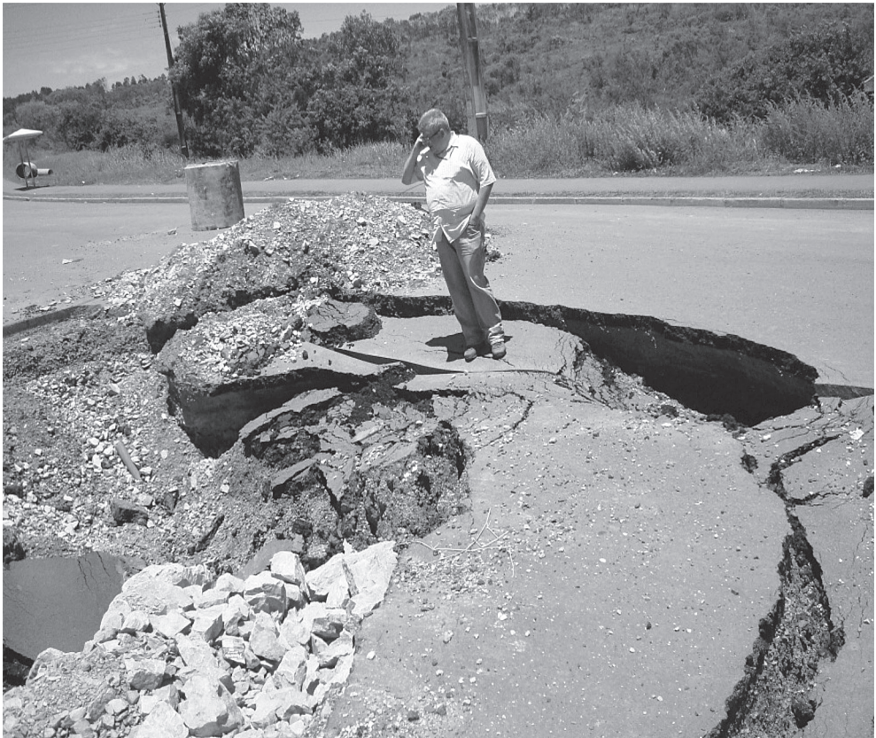
Figura 5 – Buraco formado pela acomodação do solo em via pública próximo ao centro da cidade de Almirante Tamandaré
