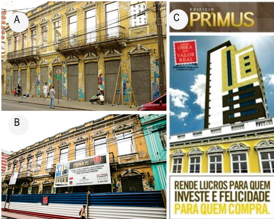
Figura 5: (A) Fachada antes; (B) Fachada durante a intervenção; (C) Marketing da incorporadora imobiliária sobre o projeto
