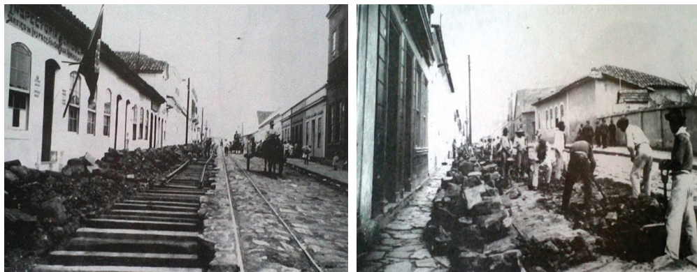
Figura 1 – Obras de colocação dos trilhos dos bondes na rua Riachuelo
