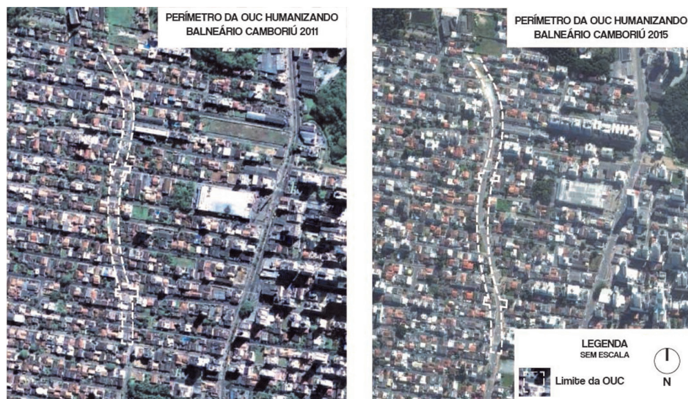
Figura 5 – Perímetro da OUC Humanizando Balneário Camboriú antes (2011) e após as obras (2015)
