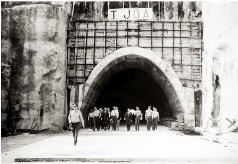
Figura 4 – Obra túnel do Joá, anos 1970
