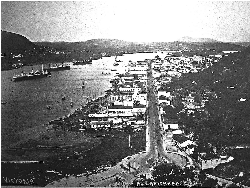
Figura 4 – Cais e condições das obras – 1914
