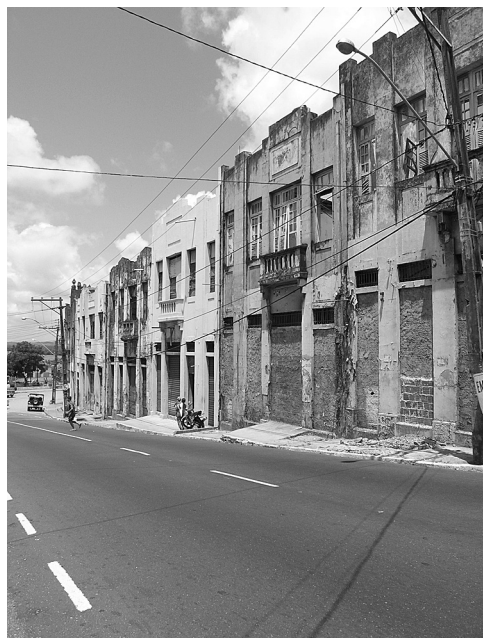
Figura 10 – Conjunto de casas da Rua São Suassuna
