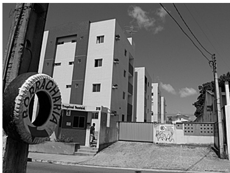
Figura 13 – Residencial Tambiá, em João Pessoa
