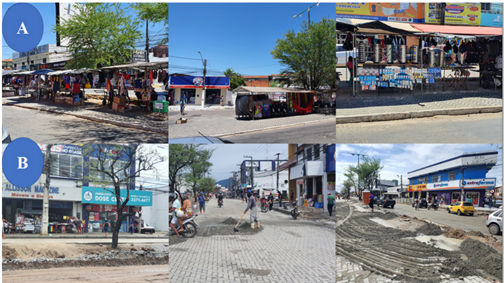
Figura 1 – Feira do Calçadão e obra de requalificação da avenida Carlos Jereissati
