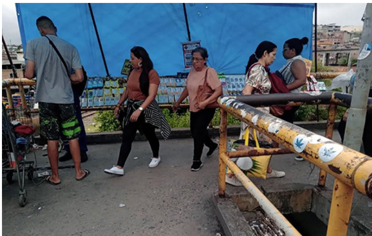
Figura 4 – Foto da passarela de acesso à estação de metrô da Pavuna em que se observa bancada de venda informal se utilizando do guarda-corpo metálico da rampa como suporte. À direita vemos uma barra metálica prefixada no guarda-corpo metálico da rampa, pronta para servir de suporte para outro expositor ou lona
