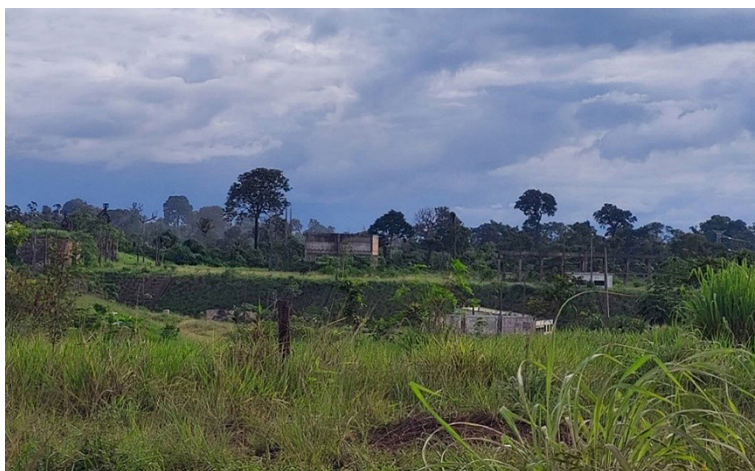
Figura 2 – Estrutura industrial abandonada e tomada por vegetação no DIM, em 2022
