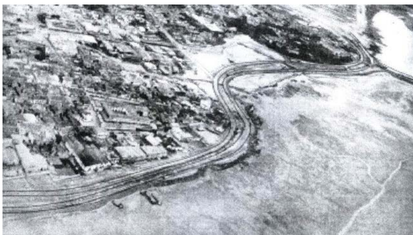
Figura 3 – Ligação de parte do futuro anel viário com a barragem do Bacanga
