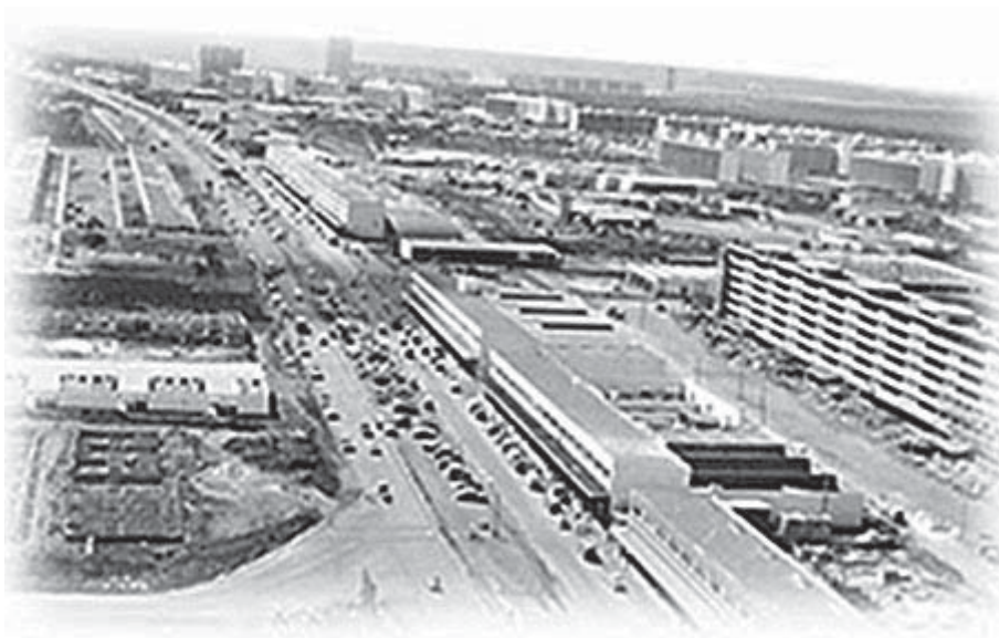
Figura 5 – Construção de Brasília, dos anos 1970 (Arquivo Público do Distrito Federal)
