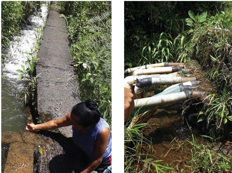
Figura 4 – Extravasor da EPM e captação de água pelos moradores, à meia encosta
