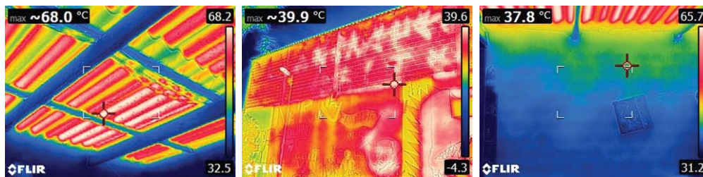
Figura 11 – Montagem com fotos termográficas da casa 4
