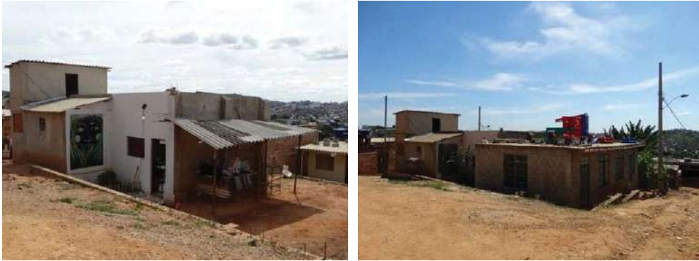
Figuras 8 e 9 – Creche Tia Carminha um mês após a sua inauguração, em maio de 2015, e após a conclusão das obras de ampliação, em abril de 2017, respectivamente
