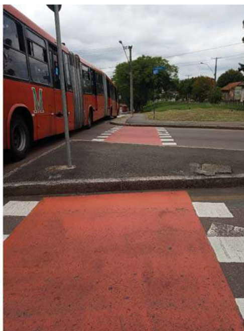
Imagem 2 Inexistência de rampa – rua Santo André versus avenida Pres. Affonso Camargo (Capão da Imbuia)
