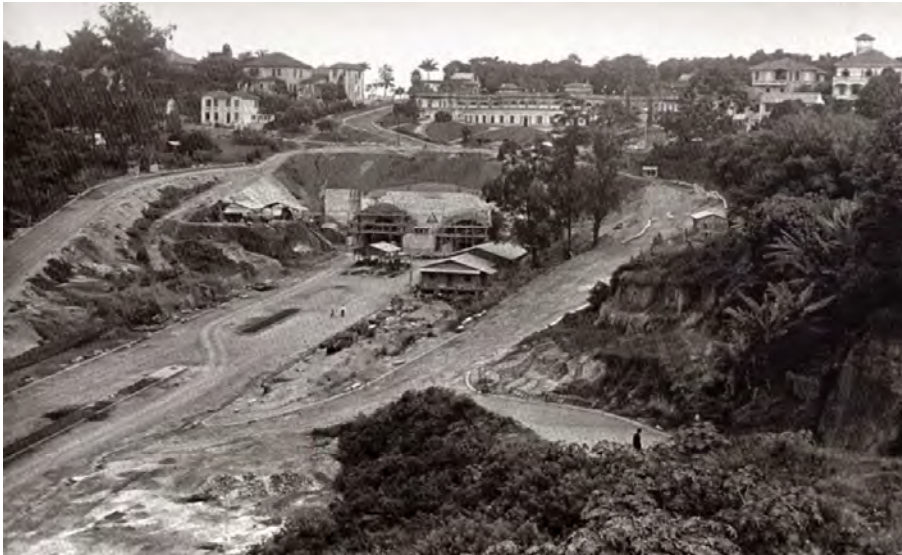
Figura 3 – Túnel da avenida 9 de Julho em construção, com o Belvedere Trianon, 1939
