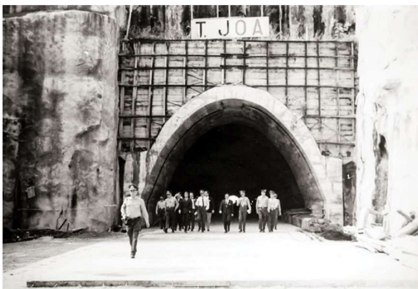
Figura 4 – Obra túnel do Joá, anos 1970
