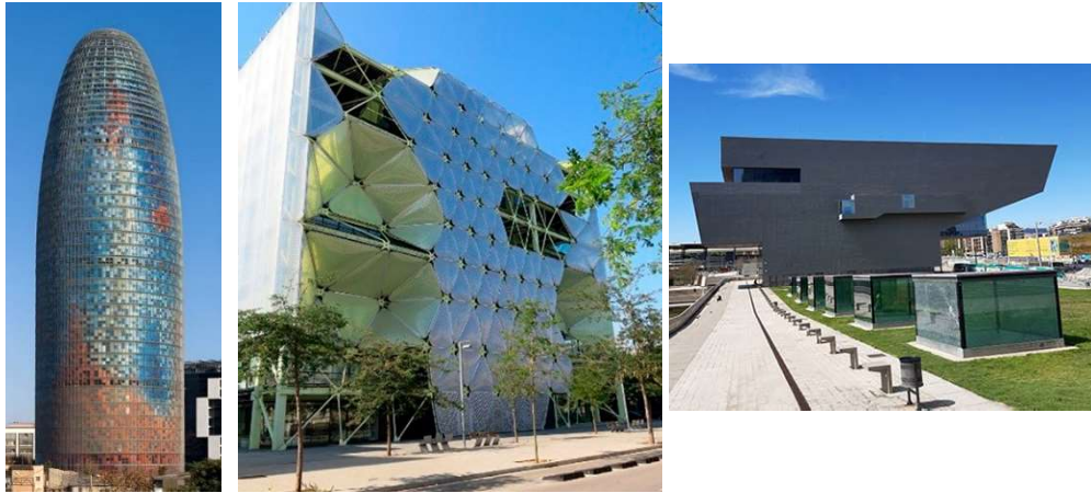
Figura 3 – Edificios singulares: Torre Glòries, Media-TIC y Disseny Hub Barcelona (de izquierda a derecha)
