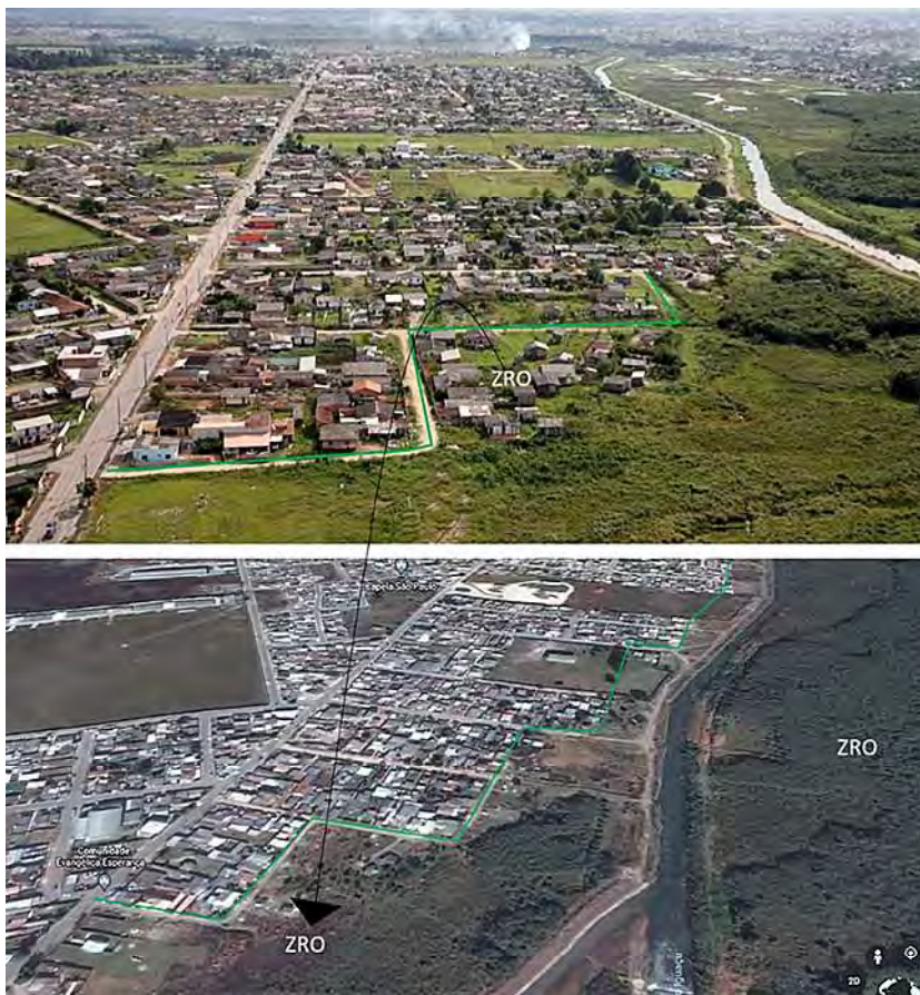
Figura 7 – Instituição da APP no canal paralelo do rio Iguaçu – ano 2007 e 2015
