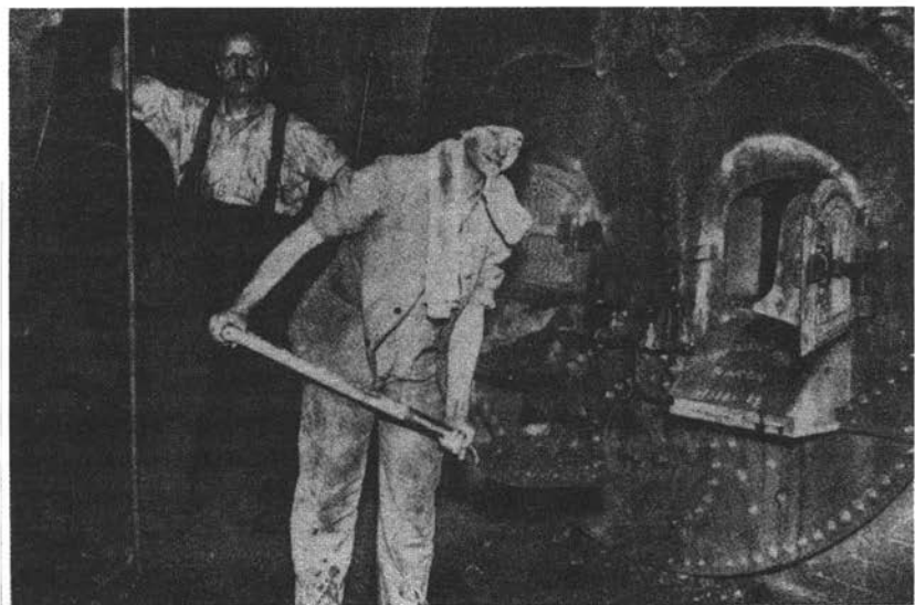
Uma mulher foguista nas fornalhas de uma grande fábrica ao sul de Londres: a exótica imagem de uma mulher de calças, 1915. (Coleção Trabalhos de Mulheres, Ministério das Provisões, 1916. Reproduzida com a permissão da Biblioteca da Universidade, Cambridge).
