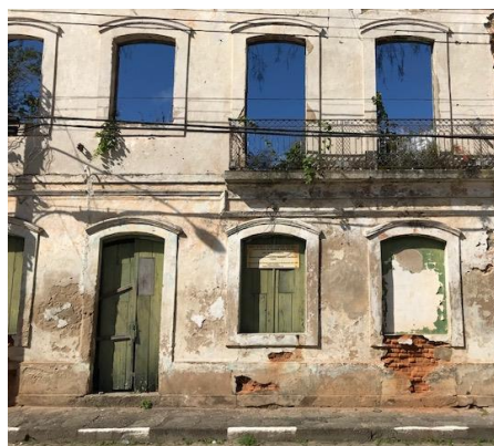
Figura 2: Situação atual da fachada lateral do prédio. Foto: Wagner Magalhães – Julho de 2018.
