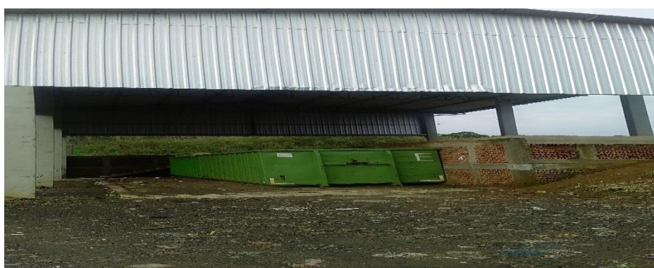
Figura 2: Espaço de despejo de resíduos sólidos urbanos
