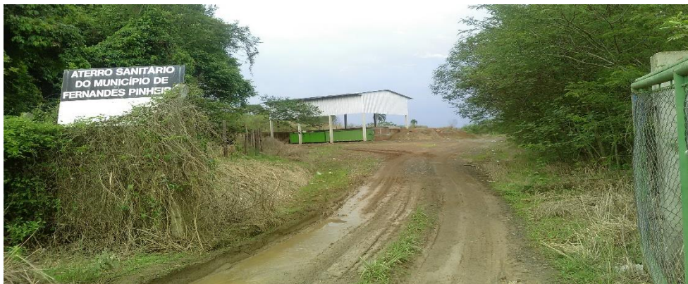
Figura 1: Estação de transbordo de resíduos sólidos
